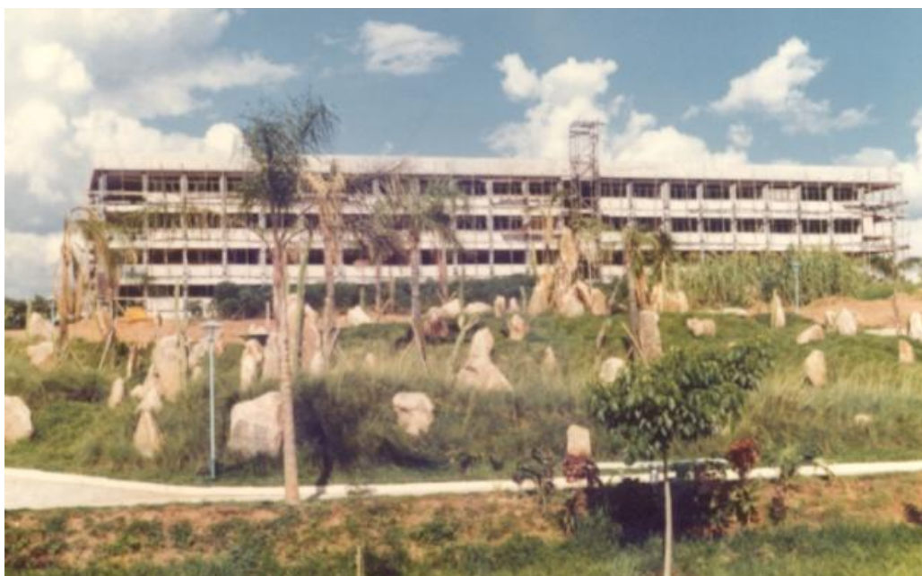
FIGURA 7 - Campus II em construção
