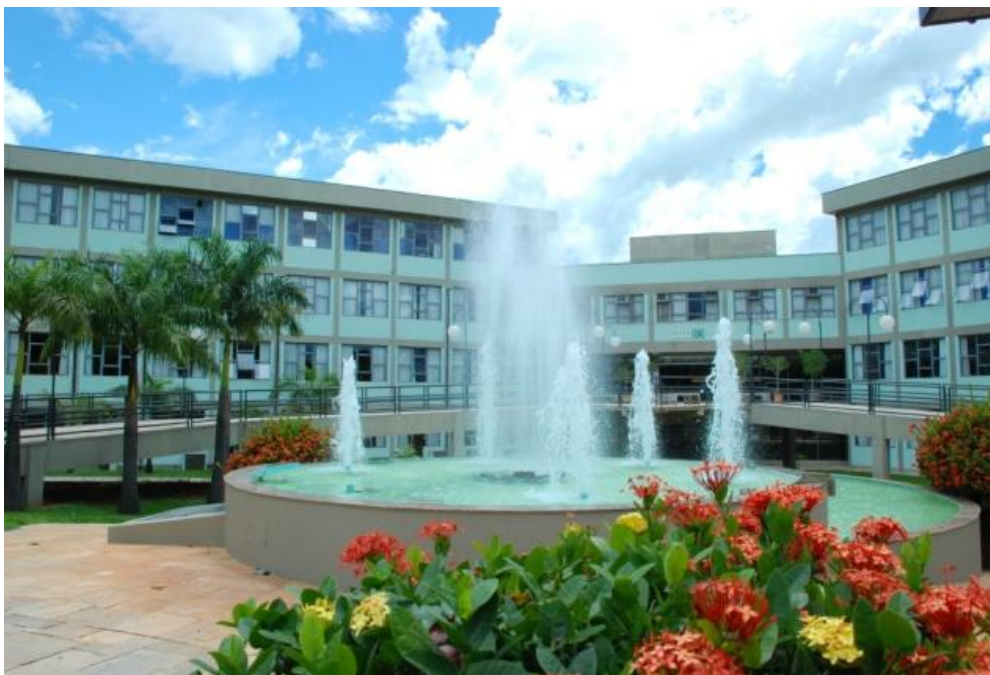
FIGURA 8 - Frente do Bloco B 3 – Campus II
