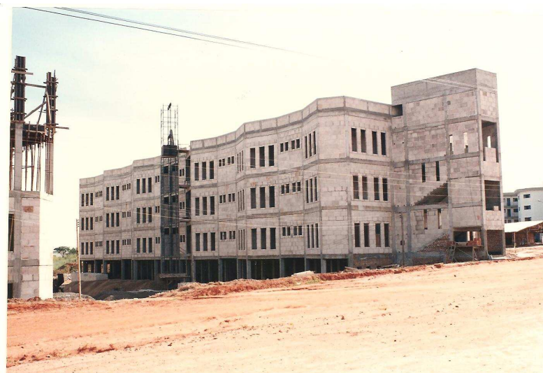
FIGURA 10 – Construção do HU, em 1990 Fonte: Arquivo Coordenadoria de Cultura Unoeste
