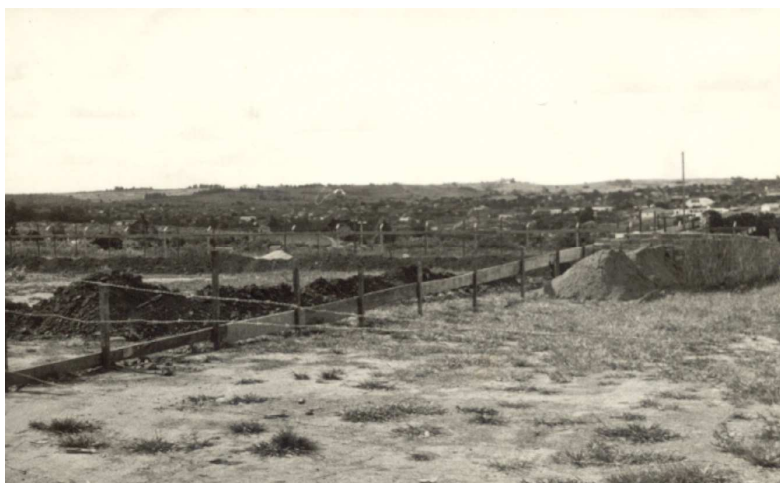
FIGURA 8 – O início da construção do campus I , em 1972 Fonte: Arquivo Coordenadoria de Cultura da Unoeste
