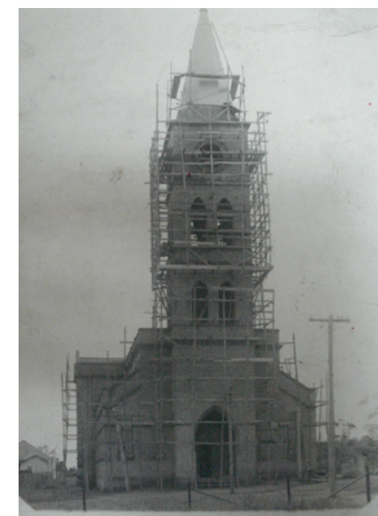
Construção Matriz Santa Bibiana em 1937
