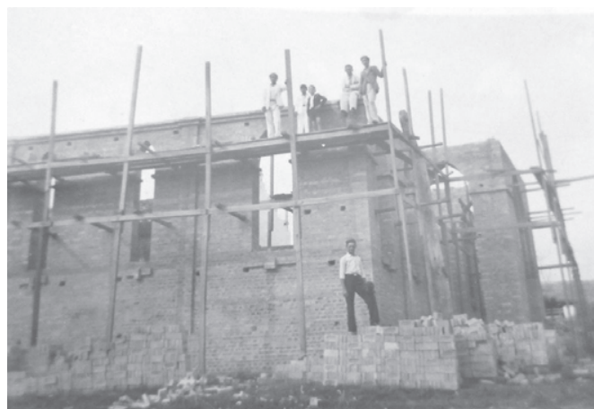
Martinópolis, 1937, construção da Igreja - último à direita no andaime, Antônio de Souza Nunes
