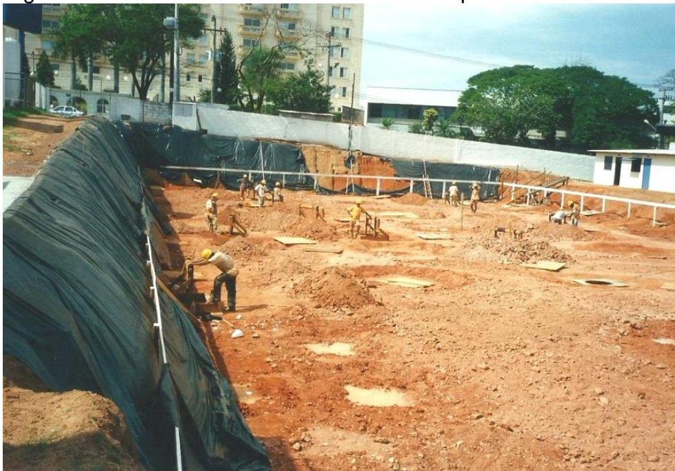
Figura 9 - Primeiros momentos da obra do hospital
