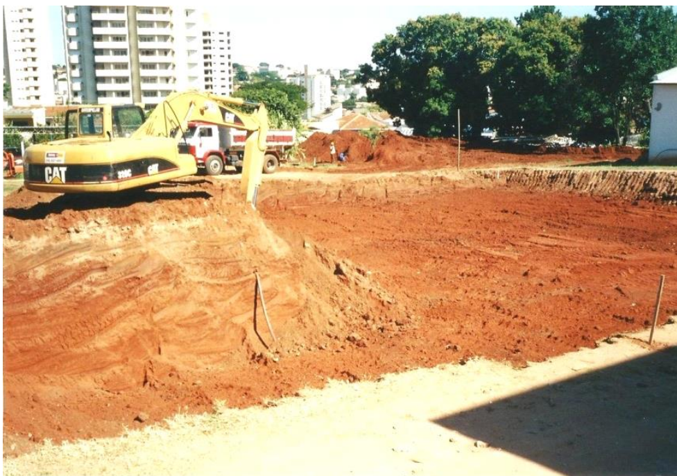
Figura 8 - Início das obras do hospital
